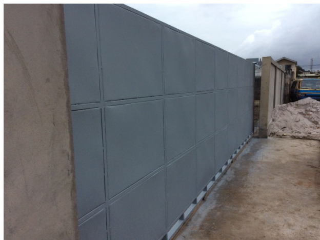
Nouvelle base GDK-Services encours d'aménagement.
