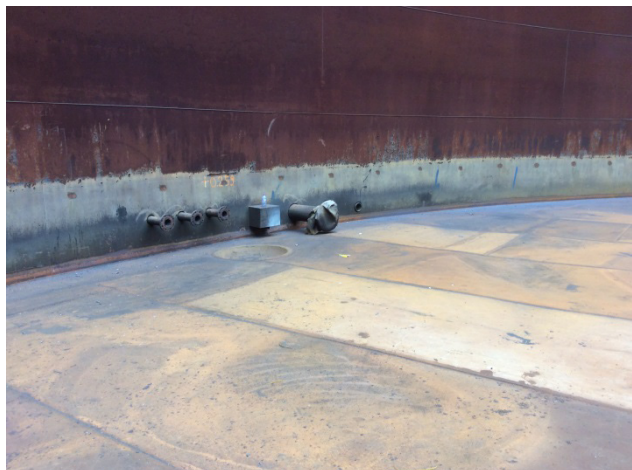
Réparation du fond d'un bac RB 9022 pour hydrocarbures
